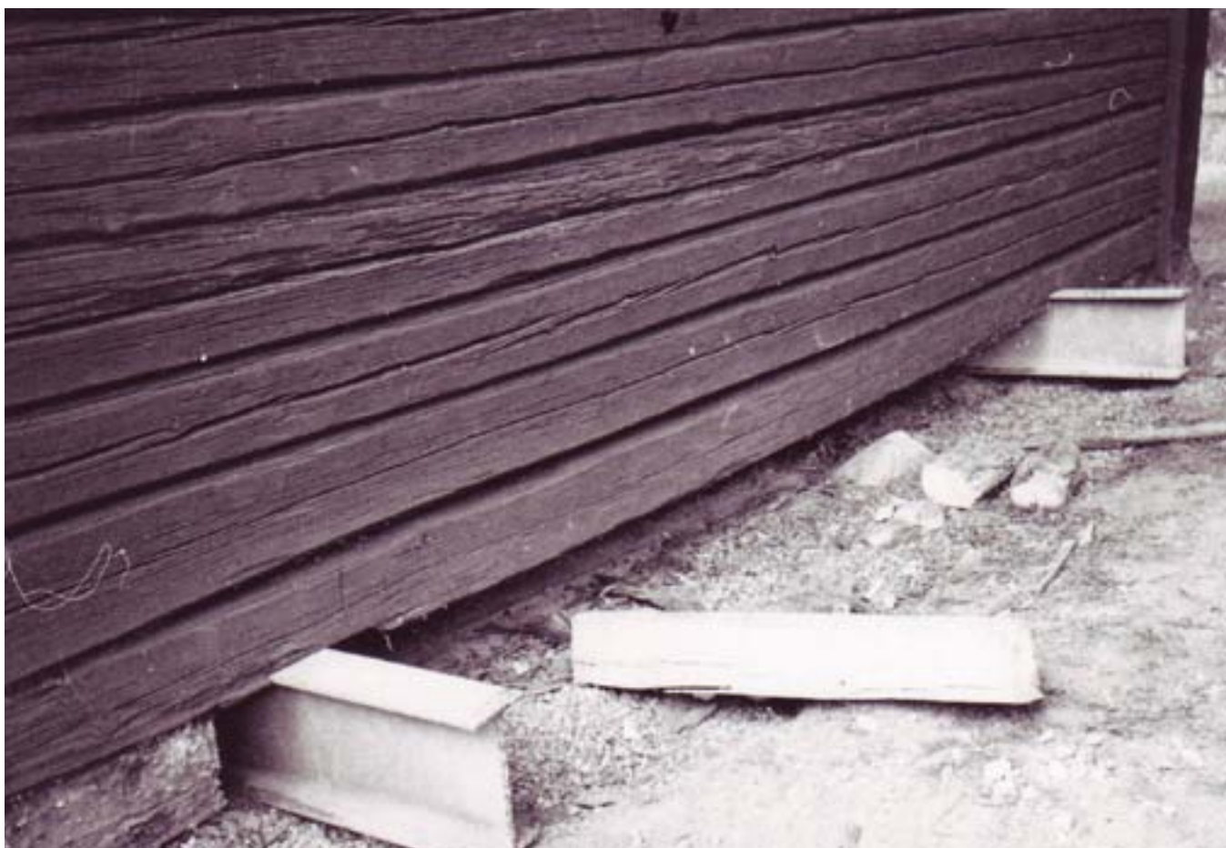
Bjälkarna på plats.
